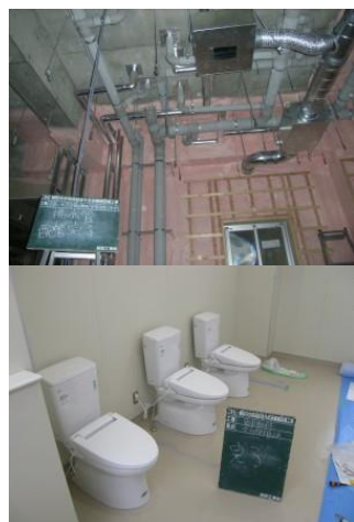
給排水・給湯設備工事
