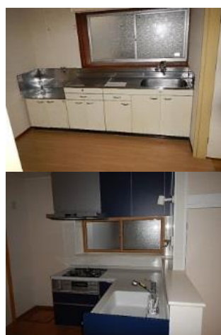
リフォーム工事
