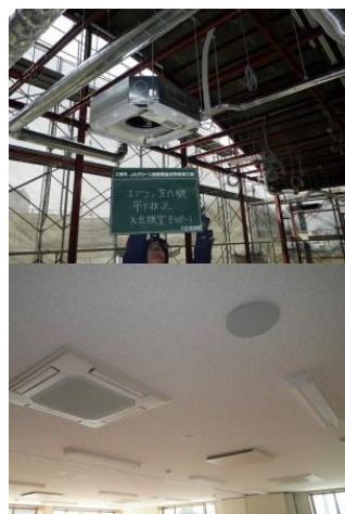
空調・換気設備工事
